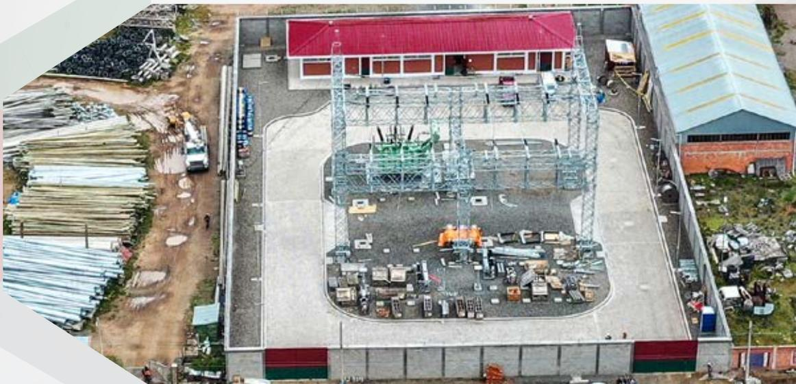
S/E Bautista Saavedra), la que tendrá un diseño del tipo convencional, barra simple, compuesta por equipos convencionales, proyectada para recibir líneas de subtransmisión y para un transformador de potencia.
