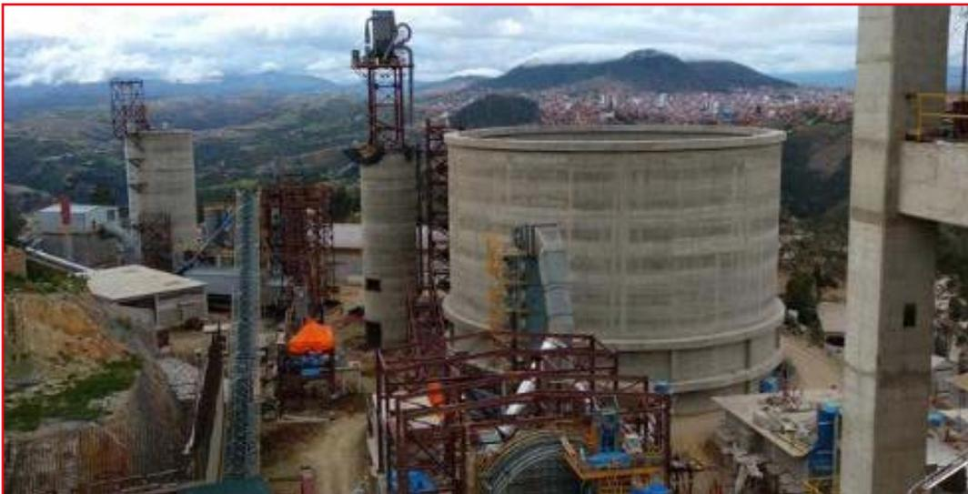
Durante la gestión 2019 se llevó a cabo la construcción de los silos del Proyecto, para el vaciado de hormigón en los silos se utilizó la tecnología de encofrados deslizantes que permiten una mayor calidad y velocidad de construcción, además del ahorro en materiales, economía de tiempos y mejores acabados.
