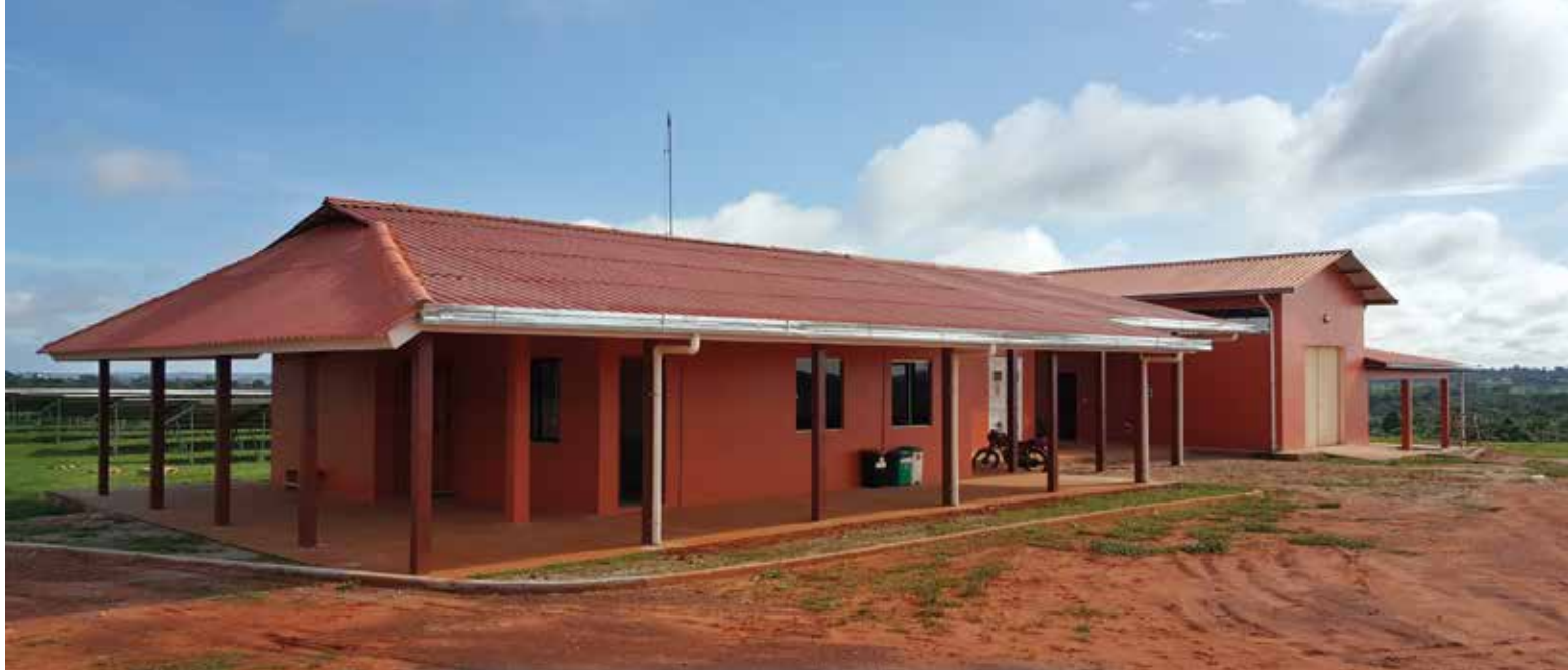
Sala de Capacitación y Oficinas Administrativas Planta Solar Cobija
