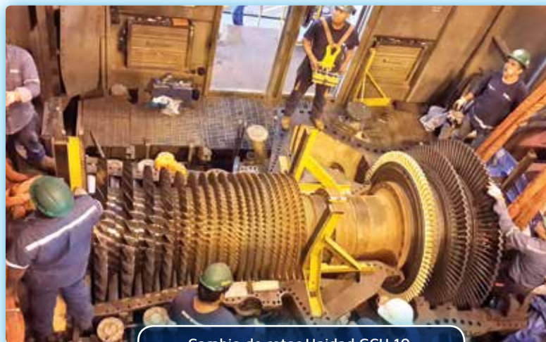
Cambio de rotor Unidad GCH 10
