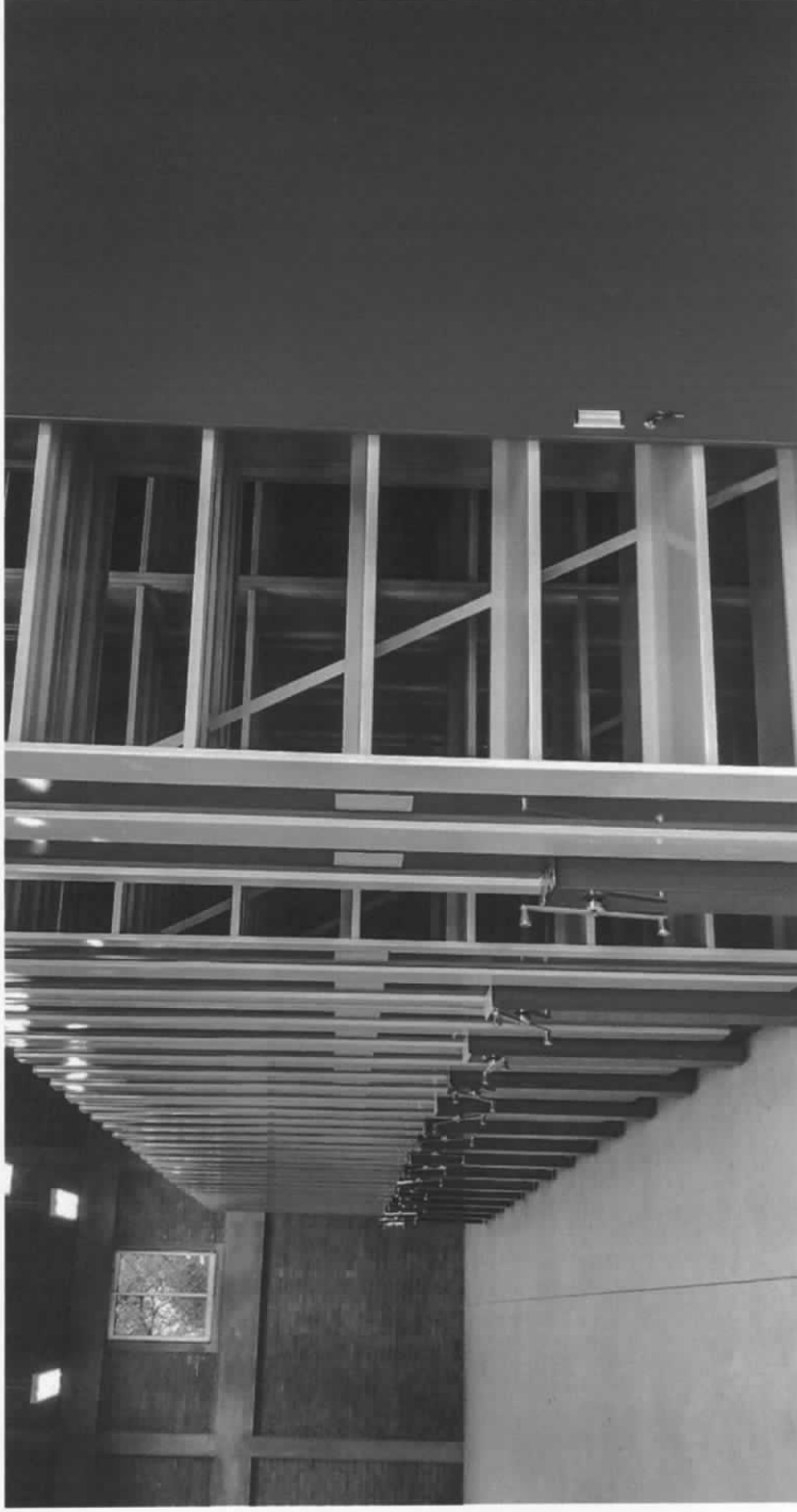
Edificio de Archivos - Central Termoeléctrica Valle Hermoso
