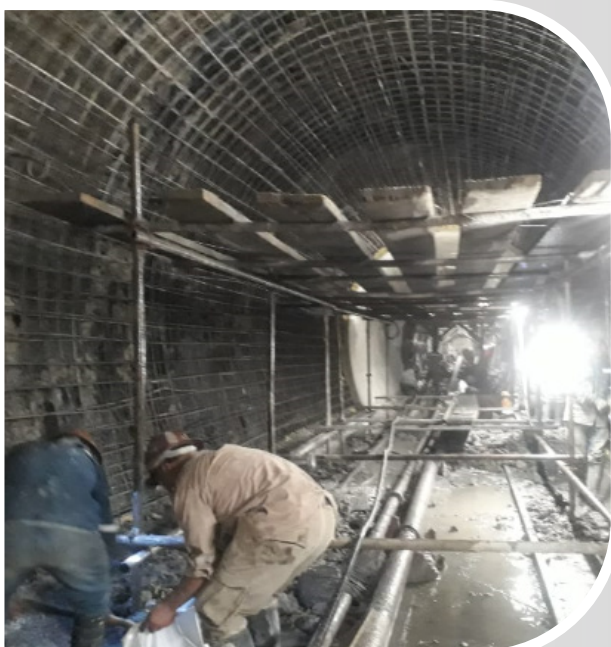
Revestimiento tramo final – Túnel Sehuencas
