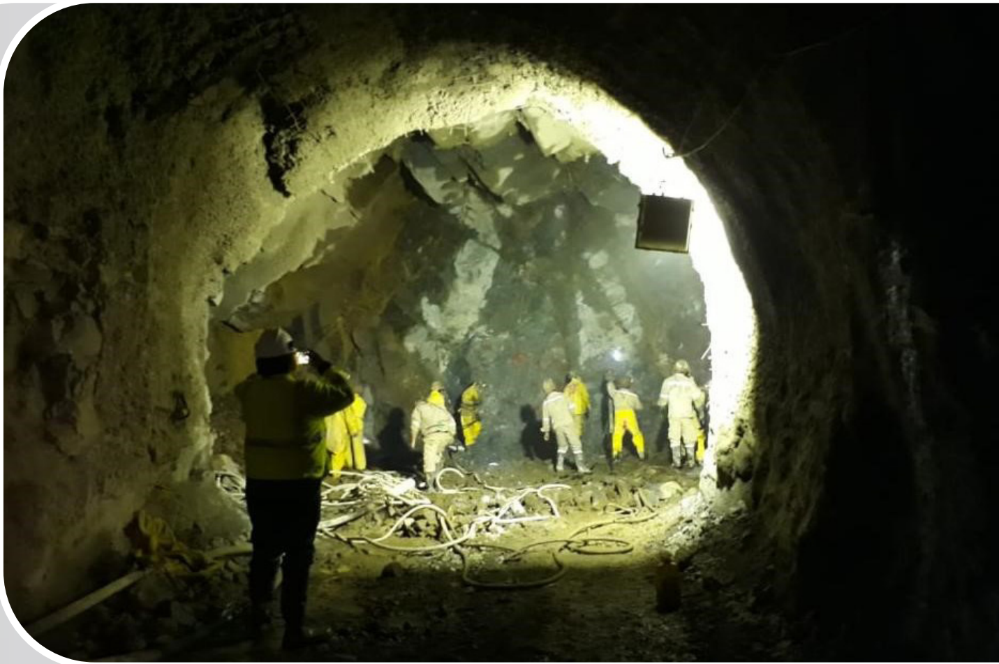
Excavación primer ensanche – Chimenea Sehuencas
