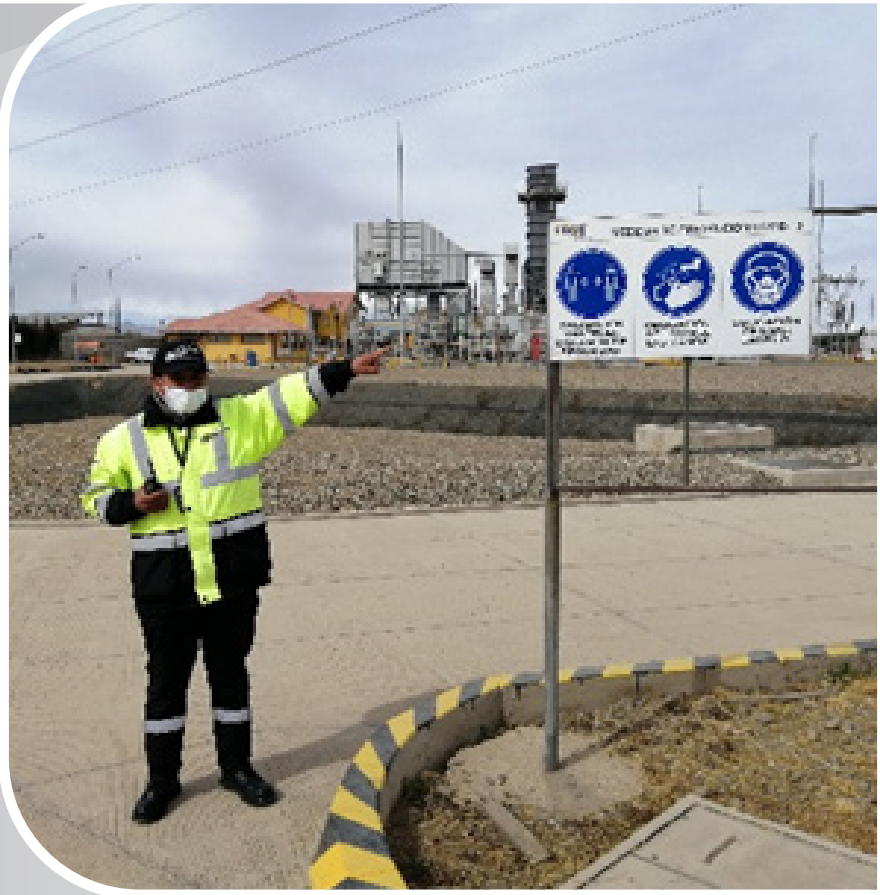
Señalización de cumplimiento obligatorio de medidas de bioseguridad al ingreso a centros de trabajo (Central Termoeléctrica El Alto)
