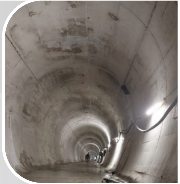
Revestimiento tramo F2 – Túnel Sehuencas
