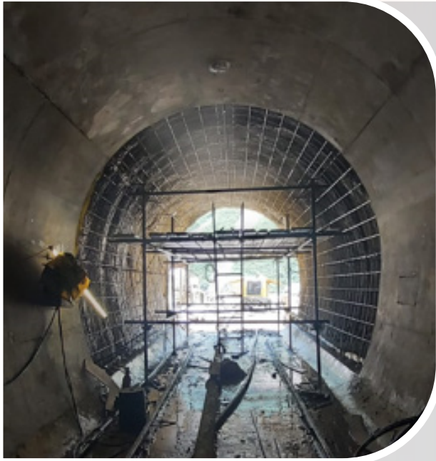
Revestimiento tramo final – Túnel Sehuencas
