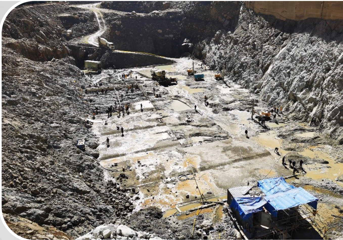
Excavación presa Sehuencas
