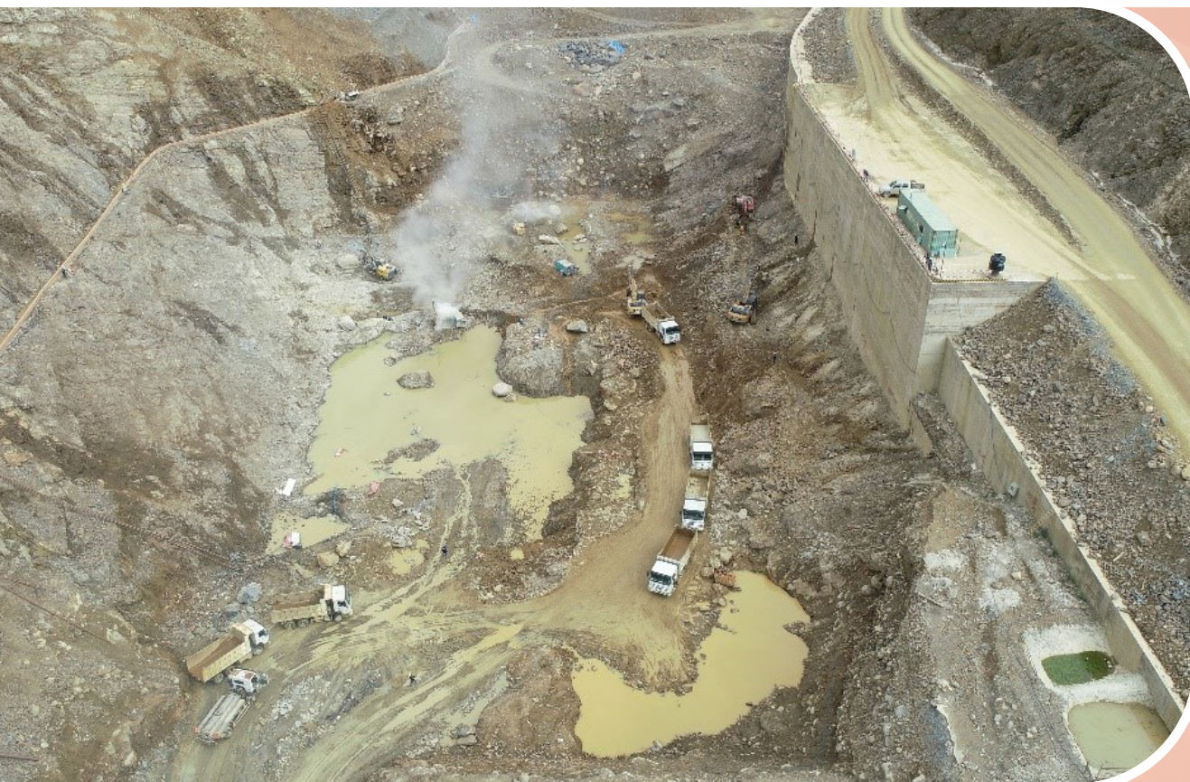
Excavación presa Sehuencas
