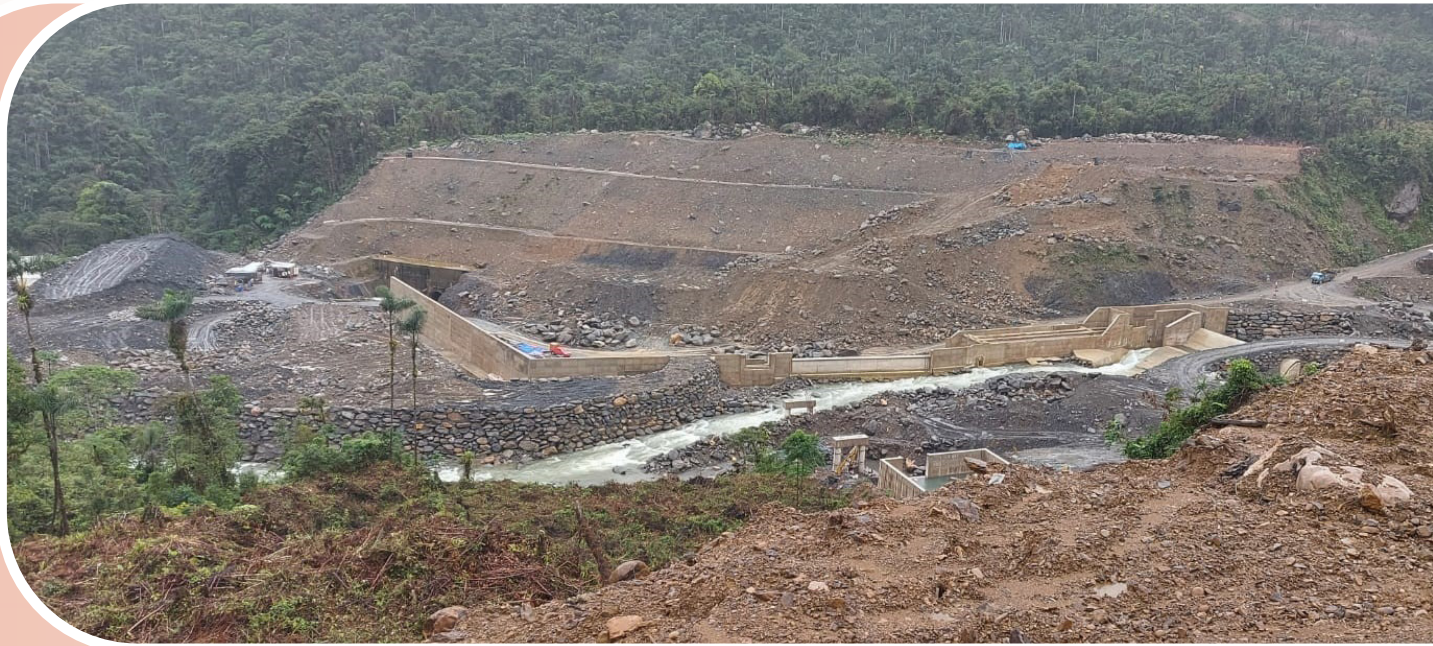
Obra de Toma Juntas
