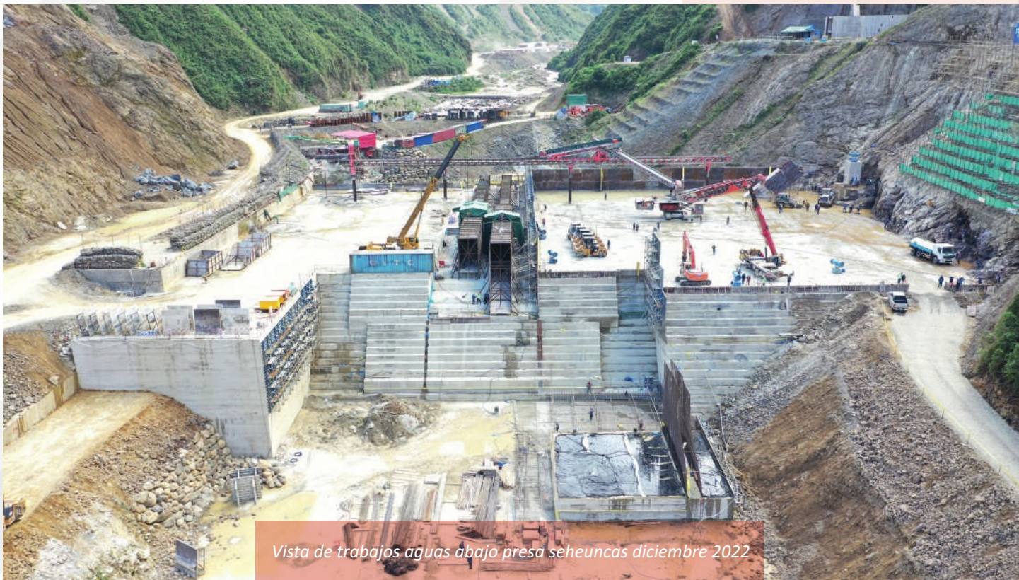
Colocado de HCR Presa Seheuncas Septiembre 2022
